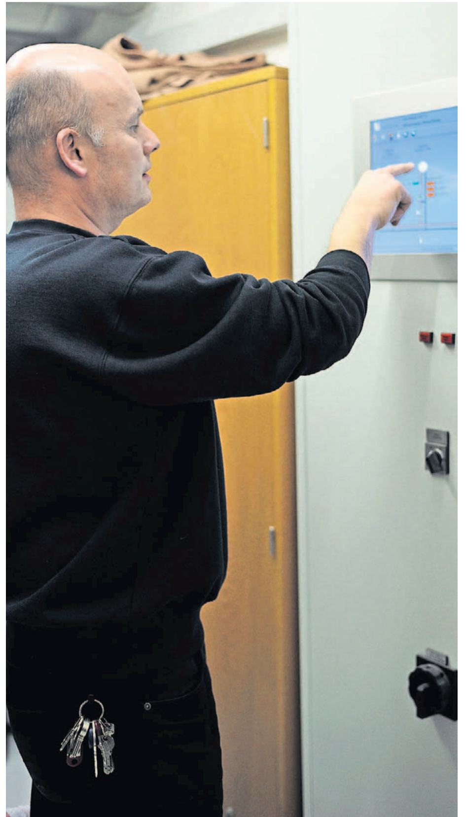
Steuergelder sparen per Touchscreen: Marcel Zimmermann, Hauswart der Bau- und Umweltschutz-Direktion, reguliert im Keller den Stromverbrauch.
