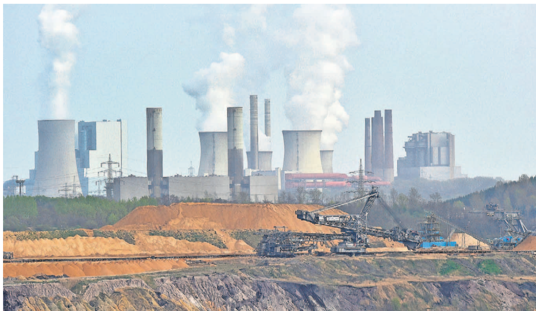
Kohleabbau in Garzweiler, Westdeutschland: Kohlestrom erlebt in Deutschland eine Renaissance, er ist billig und überschüssig vorhanden. Durch den europäischen Stromhandel fliesst er auch in die Schweiz. MARTIN MEISSNER/KEYSTONE
