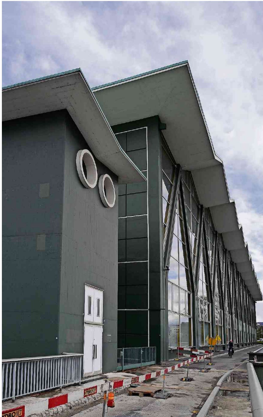
Beim Kraftwerk Birsfelden wird die Kraft des Rheins in Elektrizität für die Region umgewandelt. KENNETH NARS
