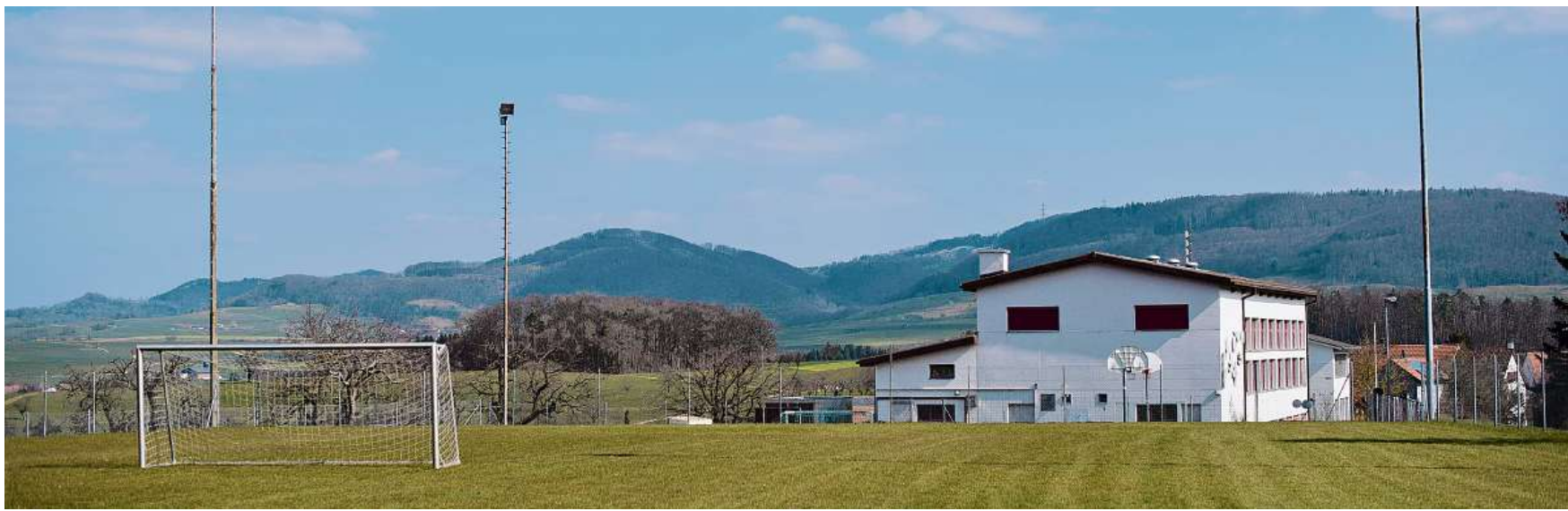
Das Dach leckt, die Heizung ist fällig. Mit der Ablehnung des Turnhallen-Neubaus wird die günstigere Sanierungsvariante wieder aktuell. Foto Florian Bärtschiger
