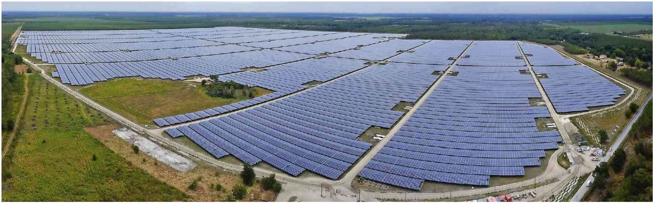
Innert zehn Monaten aufgebaut: Das grösste Solarkraftwerk Europas nahe Bordeaux, das Strom für 300 000 Haushalte produziert.
