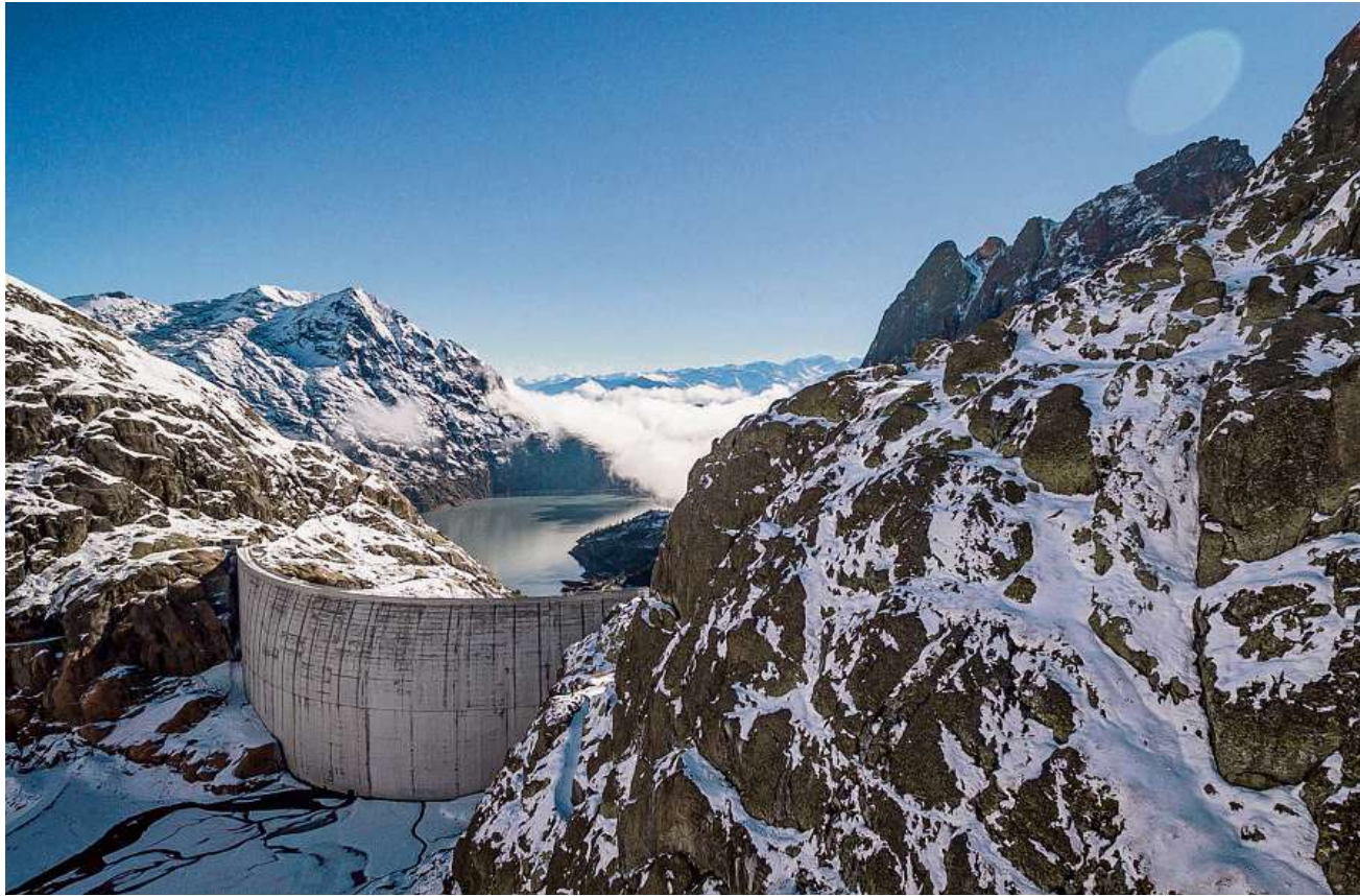
Grossinvestition für noch mehr Verlust. Für 1,8 Milliarden baut Alpiq im Gebiet Emosson mit weiteren Partnern wie den IWB, aber auch den SBB das neue Pumpspeicherkraftwerk Nant de Drance. Foto © Nant de Drance, Sébastien Moret
