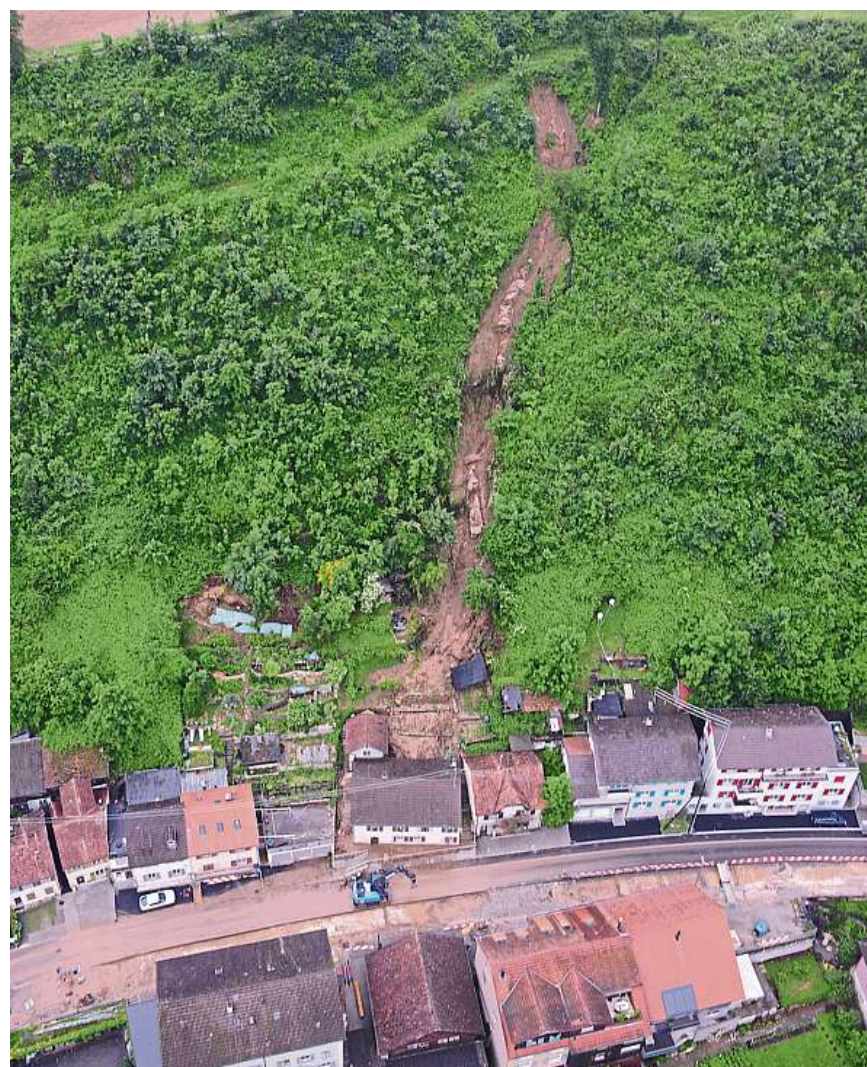
Viel zu viel Wasser im Boden. Starker Regen führte letzte Woche in Grellingen zu Hangrutschen. Mehrere Häuser mussten evakuiert werden. Foto Polizei Baselland
