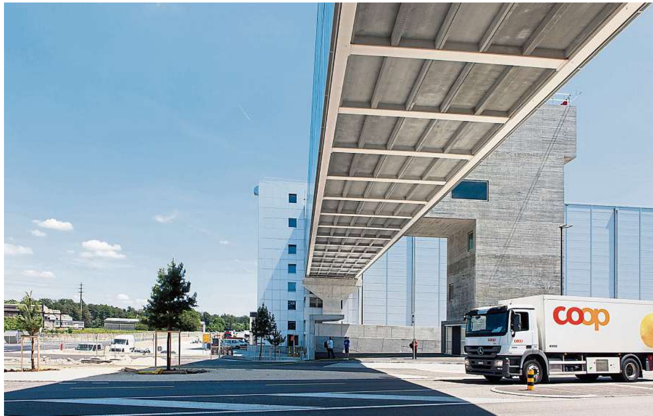
Hoch angedockt. Eine zweistöckige, 160 Meter lange Passerelle wird für den Waren- und Personenfluss genutzt.
