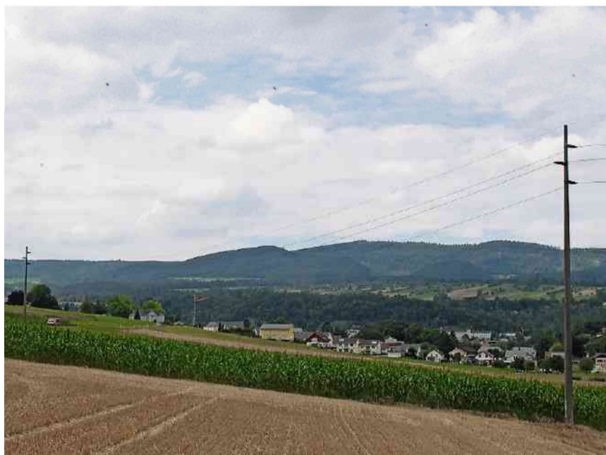
Diese EBM-Stromleitung führt von Breitenbach ins Laufner Industriegebiet HOFER
