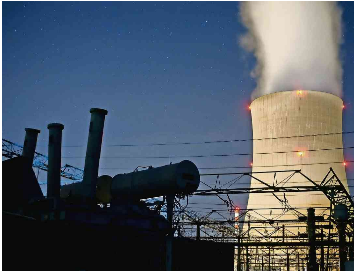
Wertberichtigungen bei den Atomkraftwerken Gösgen (Bild) und Leibstadt schlagen auf die Strompreise im Baselbiet durch. KEYSTONE
