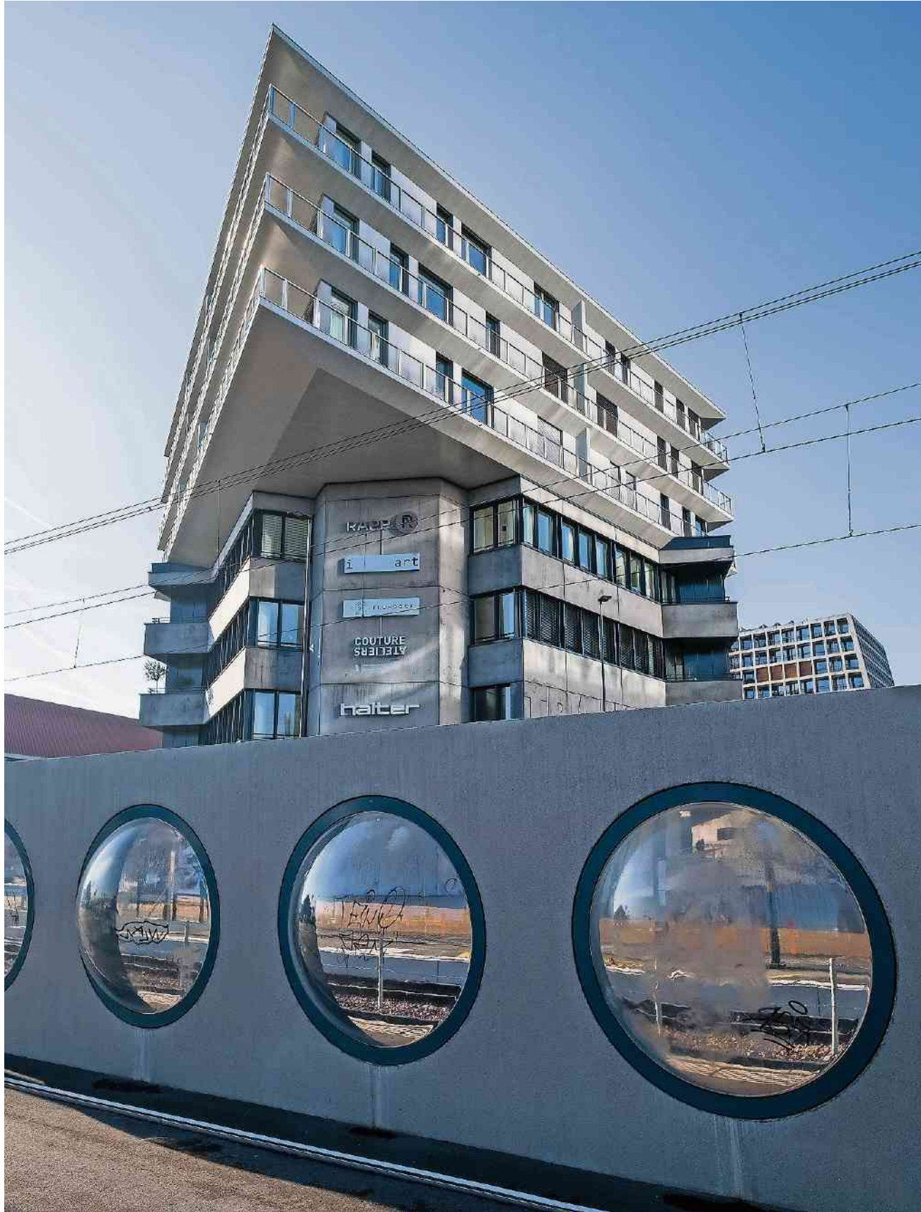
Stararchitekt Bjarke Ingels hat auf das bestehende Warenlager drei zick-zack-förmige Geschosse gesetzt.
