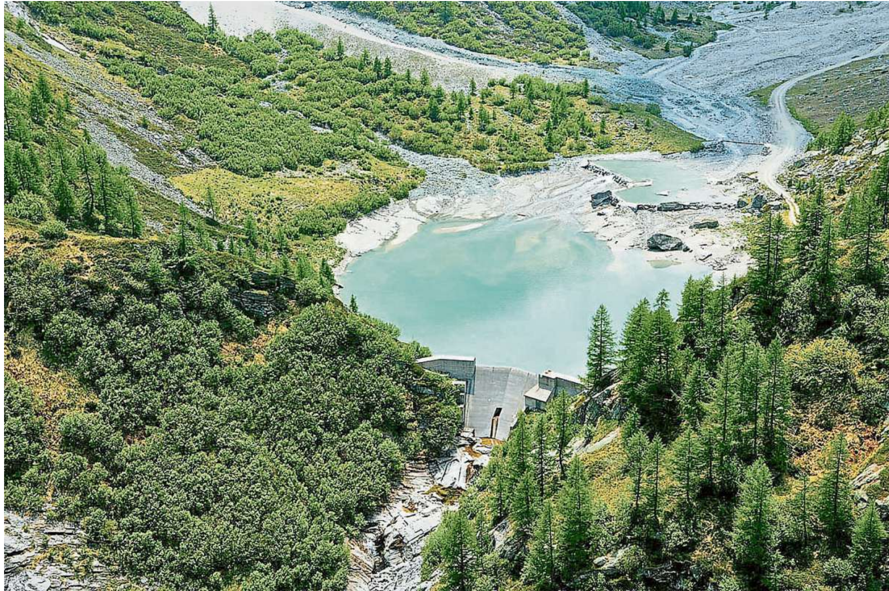
Poker um Wasserschloss Schweiz. Welche Beteiligungen die Energieversorger im Auge haben, ist geheim. Die Simplon-Speicherkraftwerke wären eine Option.
