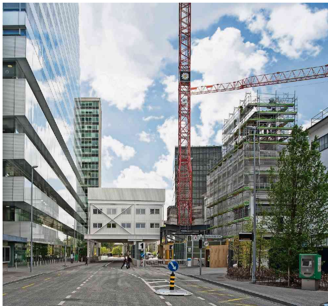
Dauerbaustelle Roche verbaut an seinem Firmensitz entlang der Grenzacherstrasse im Kleinbasel drei Milliarden Franken. Ein grosser Brocken wird der Bau 2, das dereinst höchste bewohnbare Gebäude der Schweiz: Derzeit wird das Fundament des 205-Meter-Turms vorbereitet. SEITE 20
