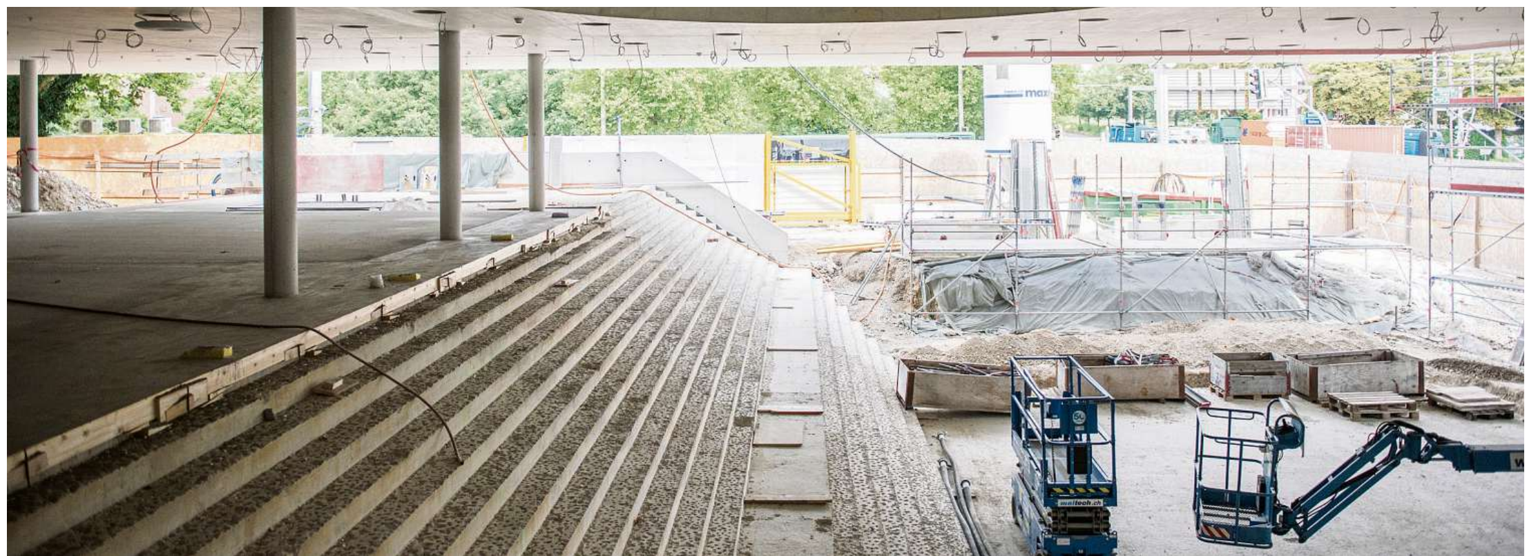
Grosszügiges Foyer. Noch wird im neuen Eingangsbereich gearbeitet, doch zu den Swiss Indoors soll dieser Teil fertig sein. Foto Florian Bärtschiger
