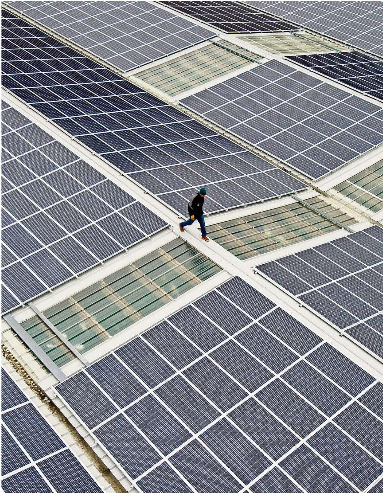
Basel droht Solardachzwang. Der Grosse Rat will Hauseigentümer dazu zwingen, Fotovoltaik-Anlagen zu montieren. Foto Key
