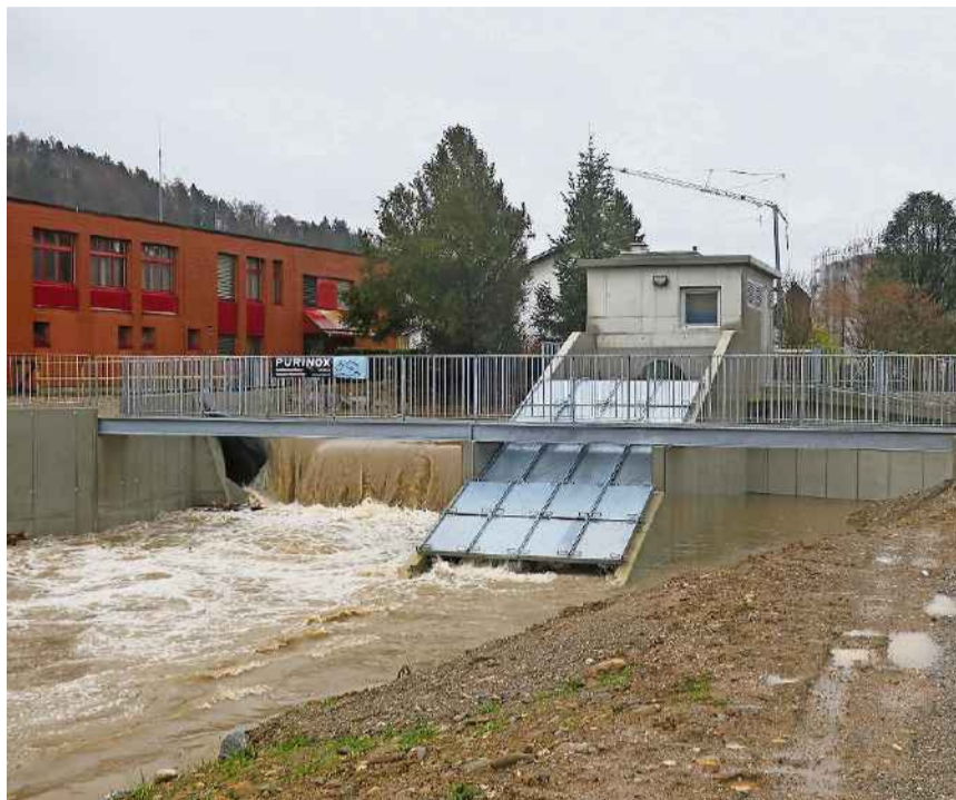
Neue Hürde für kleine Wasserkraftwerke – im Bild jenes in Schöffland. FLURINA DÜNKLI
