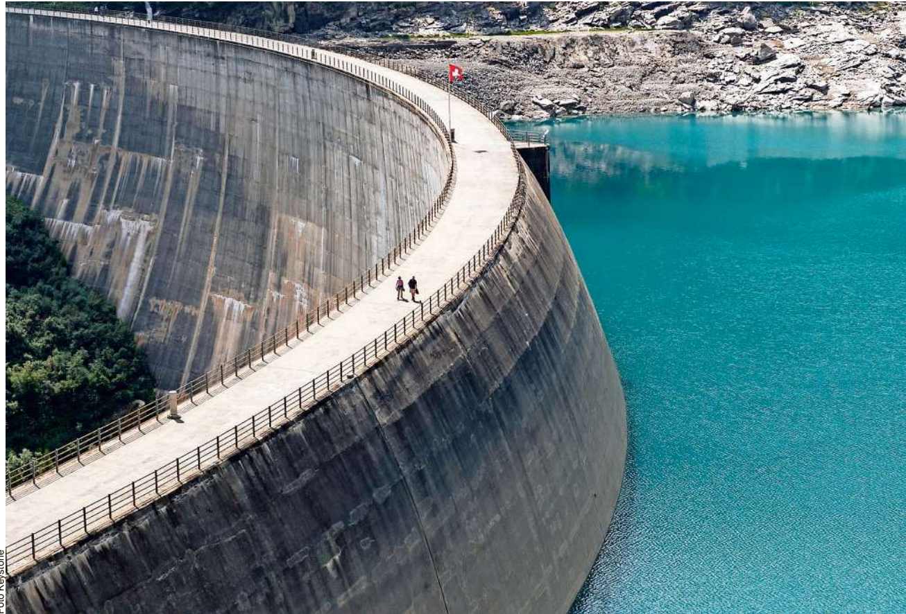
Batterie in den Bergen. Es ist denkbar, dass die Betreiber von Wasserkraftwerken zu Kapazitätsreserven in ihren Stauseen verpflichtet werden, damit die Schweiz den Winter teilweise überbrücken kann. Hier zu sehen: der Zervreila-Stausee in Vals.
