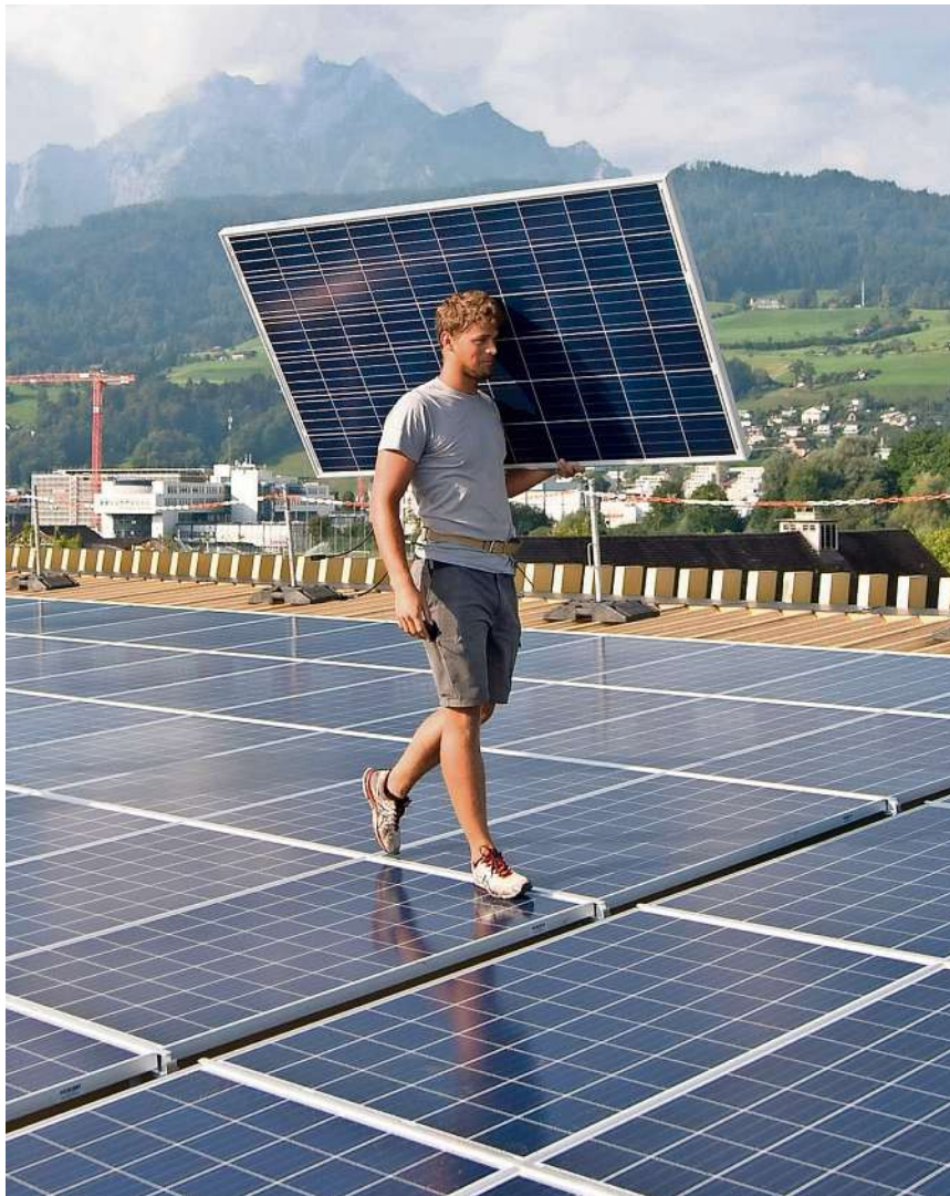
Physikalische Effekte. Mit zunehmenden Temperaturen sinkt der Wirkungsgrad von handelsüblichen Fotovoltaikanlagen. Foto Keystone
