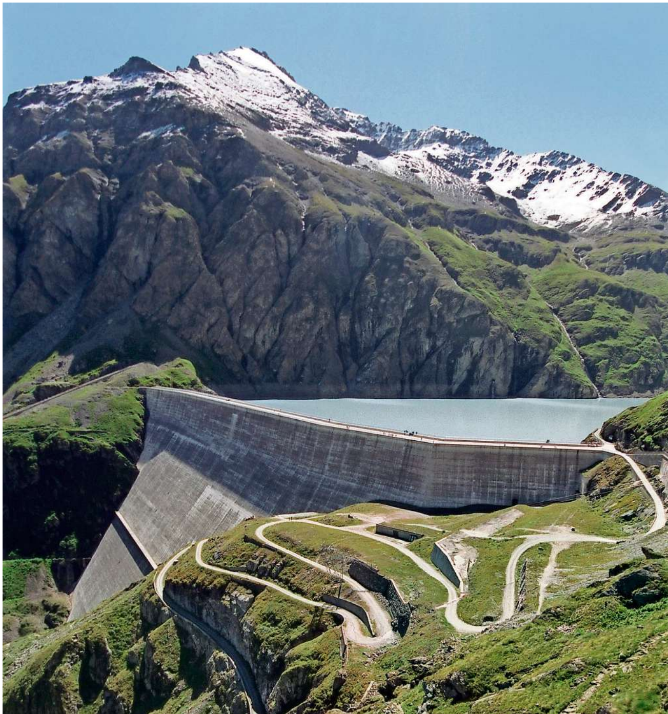
Unter Aufsicht von Beamten. Die Staumauer Grande Dixence im Wallis. Foto Keystone
