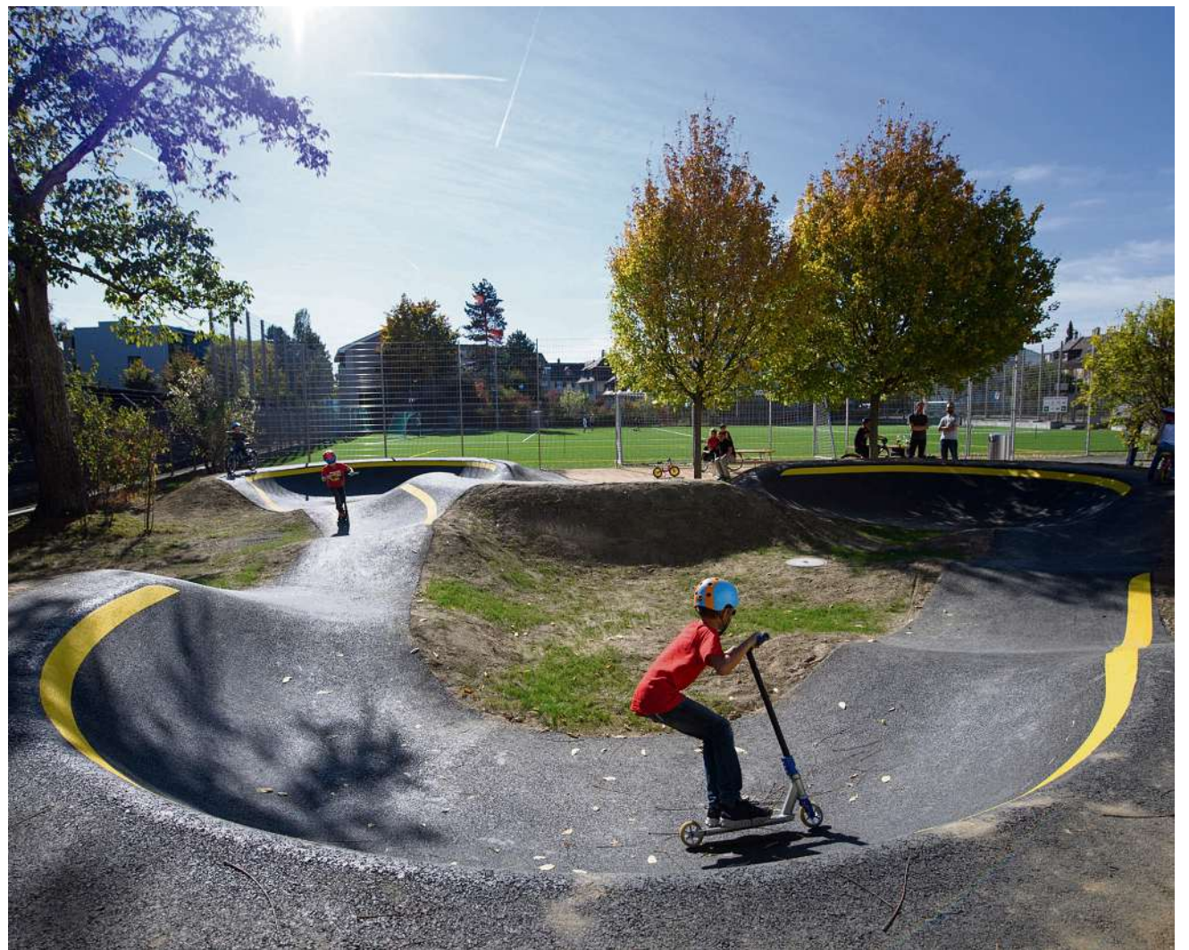
Für Bikes und Boards. Die wellige Rundbahn mit den möglichst steil abfallenden Kurven ist aus Asphalt. Foto Dominik Plüss
